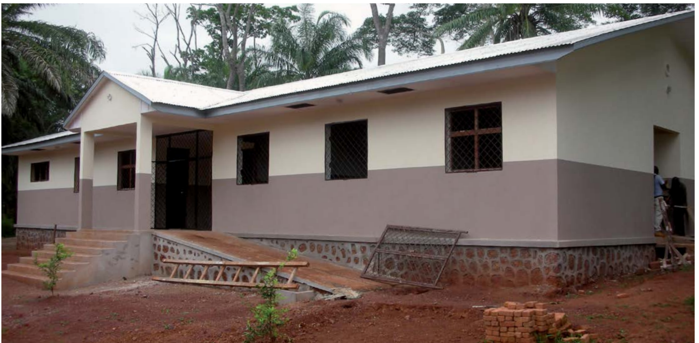
Vista exterior del quirófano de Bangondé
